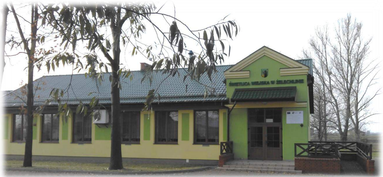
Fot. 20. Świetlica wiejska w Żelechlinie
