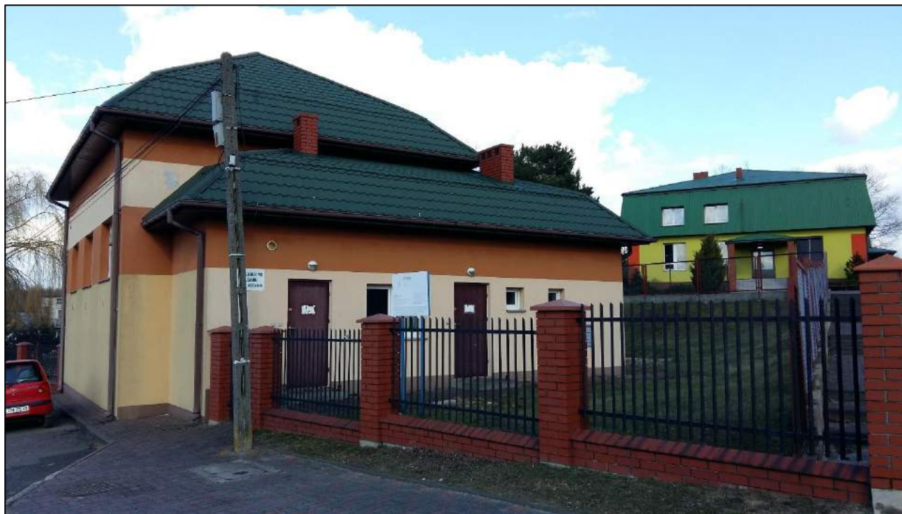
Fot. 25. Stacja uzdatniania wody w Żelechlinku
